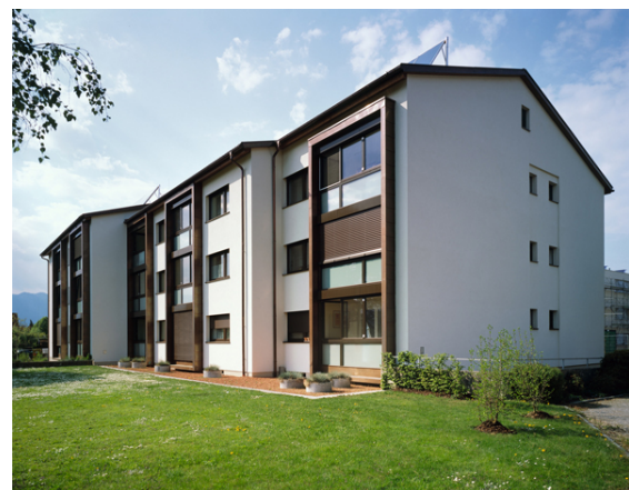
Foto: Lakóépület Rankweil-Schleipfweg felújítás után
