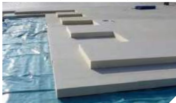
Fokozott hőszigetelés, PIR táblák két rétegben fektetve
