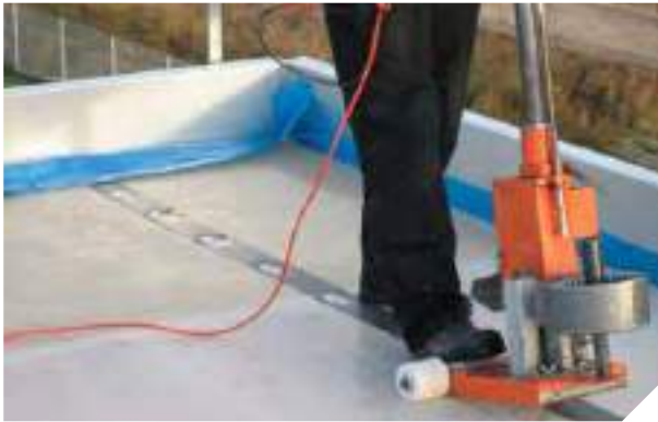
Poliuretán táblák rögzítése mechanikai módon (a csapadékvíz szigetelés alatt), dübelekkel
