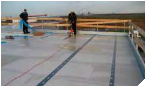
PIR táblák rögzítése sávzalagok segítségével
