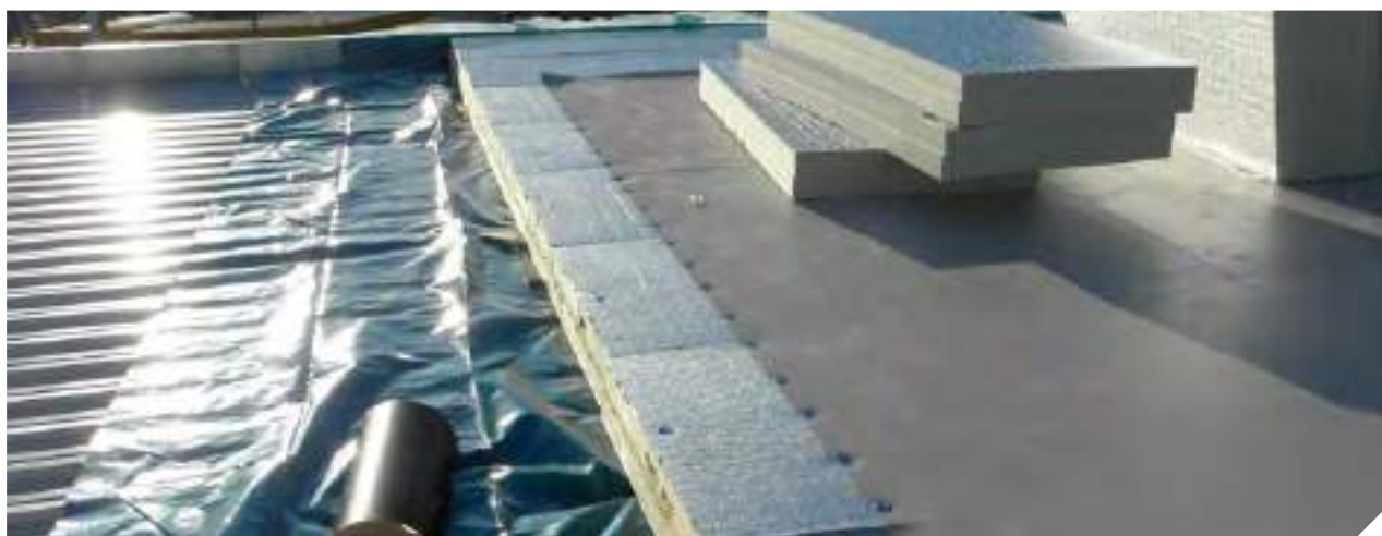
Tetőszigetelés és csapadékvíz szigetelés rögzítése
