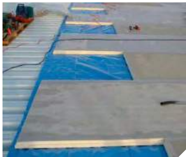
PIR MV üvegfátyol kasírozású poliuretán táblák fektetése
