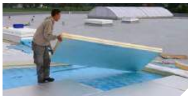
Nagyméretű (2,50 m x 1,25 m) és kimagasló merevségű alufólia kasírozású poliuretán táblák elhelyezése
