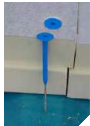
Kevesbé hőhidas süllyesztett hüvelyes műanyag perselyű dübel
