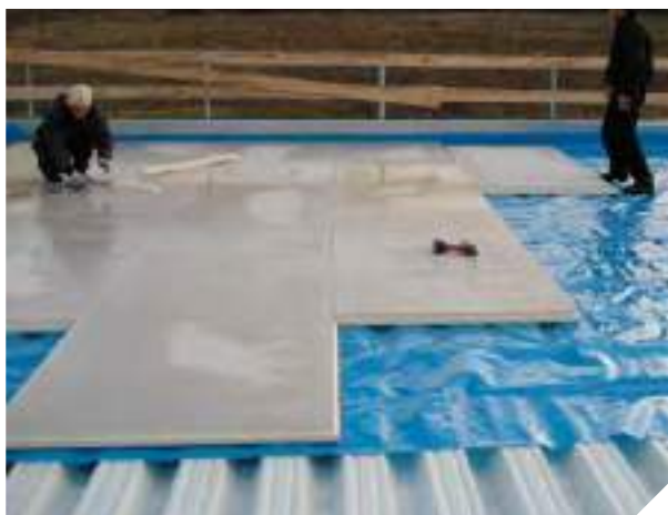
PE párazáró fólia fektetése a trapézlemezre
