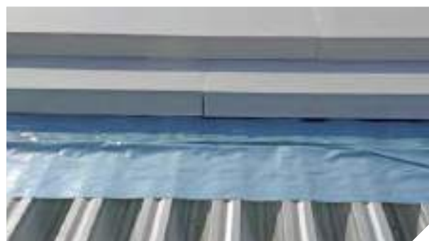
Fokozott hőszigetelés PIR táblákkal (2x14 cm)
